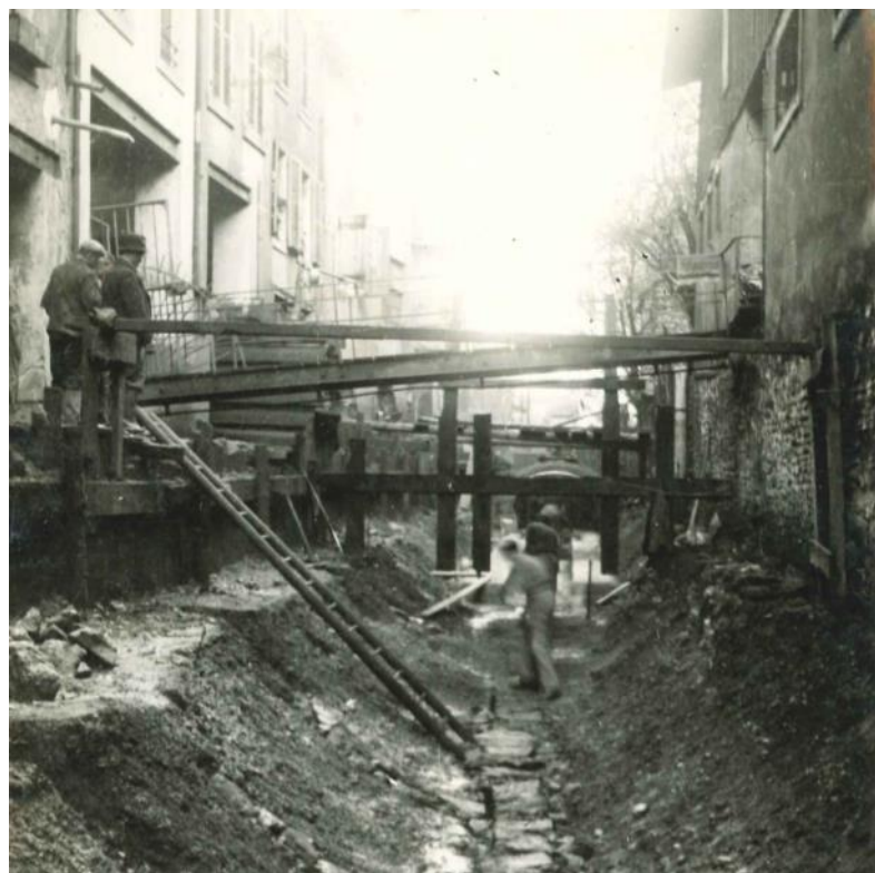
Canal de la Schliffe, couverture, 1947-1948, AMM 1Fi7651.
