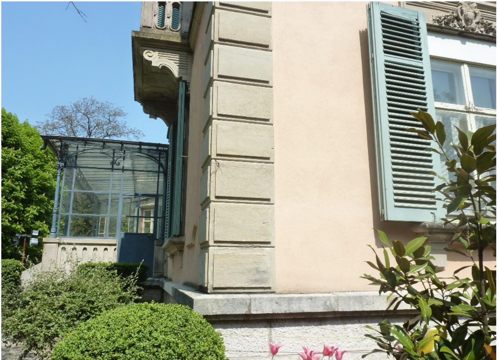
Angle de façade en grès rose des Vosges dans la partie supérieure et du calcaire en bas
